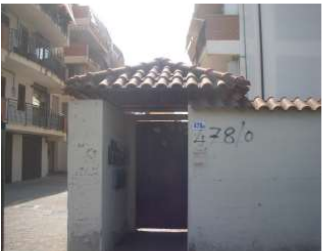
(foto 5: vista cancello pedonale)
